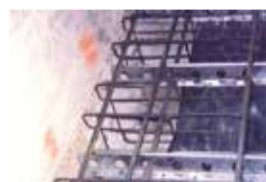
Insertion du connecteur continu LPR dans le rebord.
